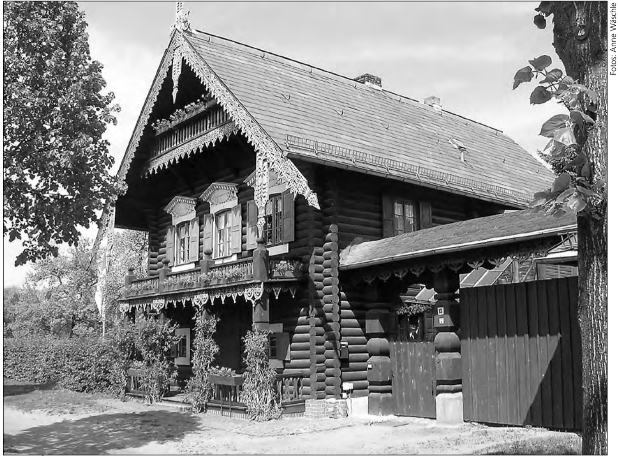
Auch wenn es ein bisschen wie im Schwarzwald aussieht, als Vorbild für die russische Kolonie diente das Dorf Glasowo bei St. Petersburg. Doch statt die Hütten mit Stroh zu decken, brachten die Militärhandwerker der preußischen Garderegimenter eine Holzverbreterung auf, die zum Ende des 19. Jahrhunderts gegen eine wetterfestere Schieferdeckung ausgetauscht wurde.
